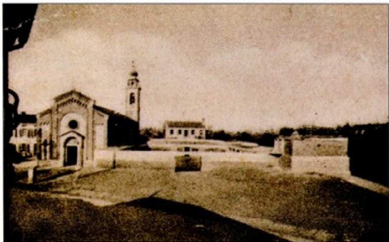
La nuova chiesa della Parrocchia di Montà in costruzione. Si noti la vecchia chiesa sulla sinistra
