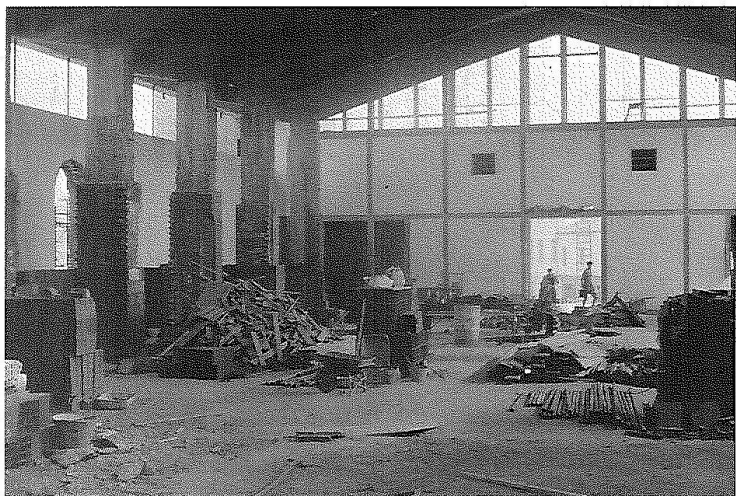
la navata della chiesa in costruzione
